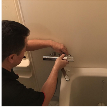
浴室水栓交換
